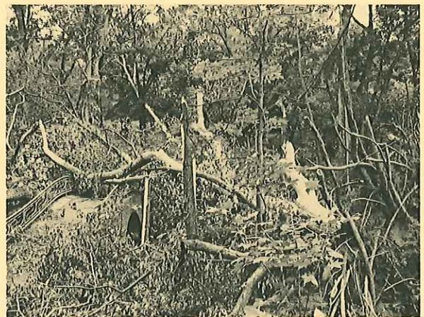
写真1. 眼鏡橋周辺の被害状況
