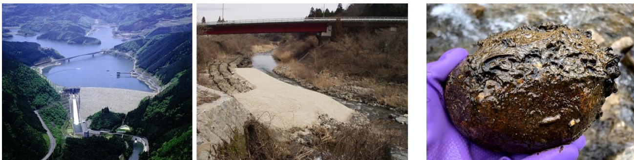
写真1 阿木川ダム全景（左）、土砂還元の様子（右） 写真2 付着藻類が厚く繁茂した石
